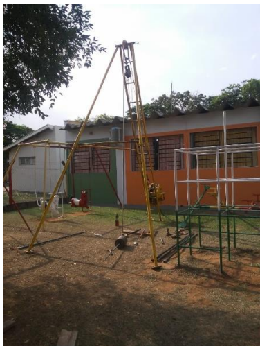
Foto 03 - Acompanhamento de sondagem
