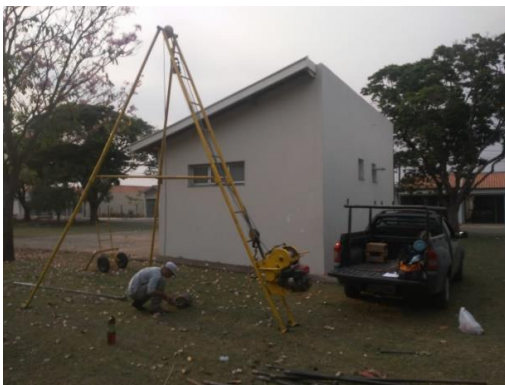
Foto 05 - Acompanhamento de sondagem
