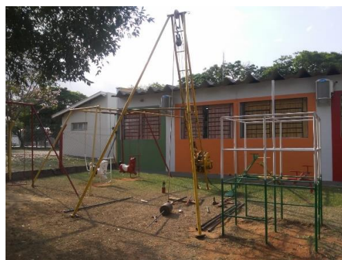
Foto 04 - Acompanhamento de sondagem
