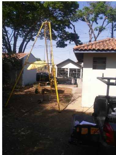
Foto 02 - Acompanhamento de sondagem
