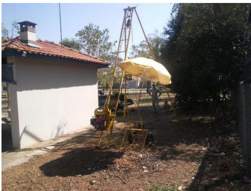
Foto 01 - Acompanhamento de sondagem
