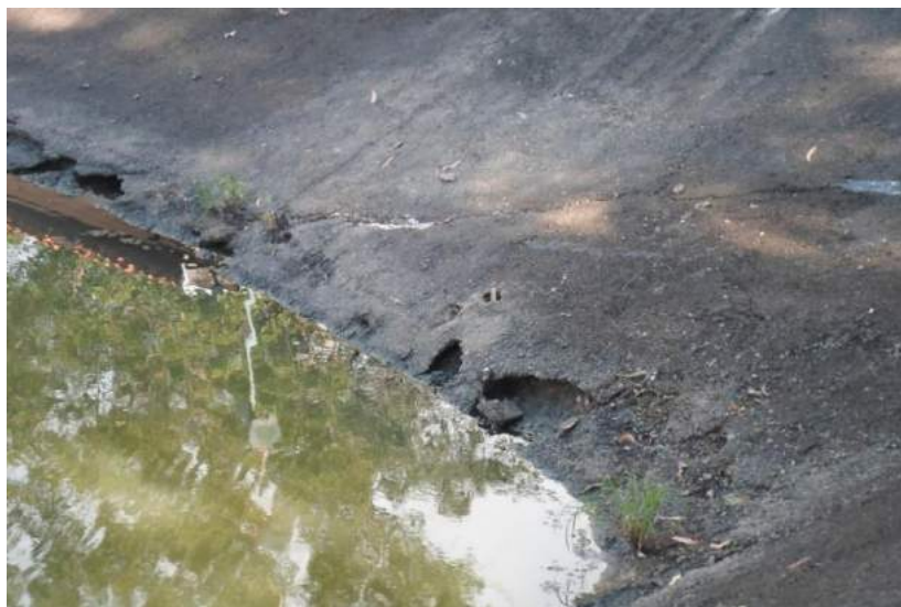
Figura 45 - Danos na estrutura do decantador.
