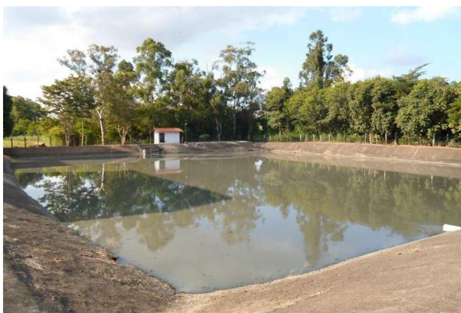
Figura 44 - Decantador da ETE.
