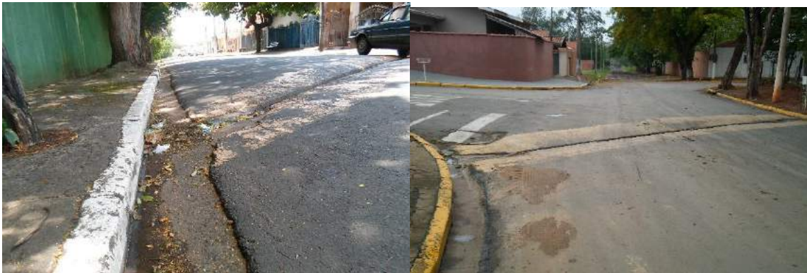
Figura 63 - Estruturas de Canaleta para escoamento Superficial de Águas Pluviais no Município de Saltinho.
