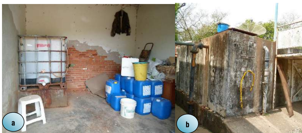
Figura 22 -a) Armazenamento dos produtos químicos b) Tanque de contato P1, P2 e P3.
