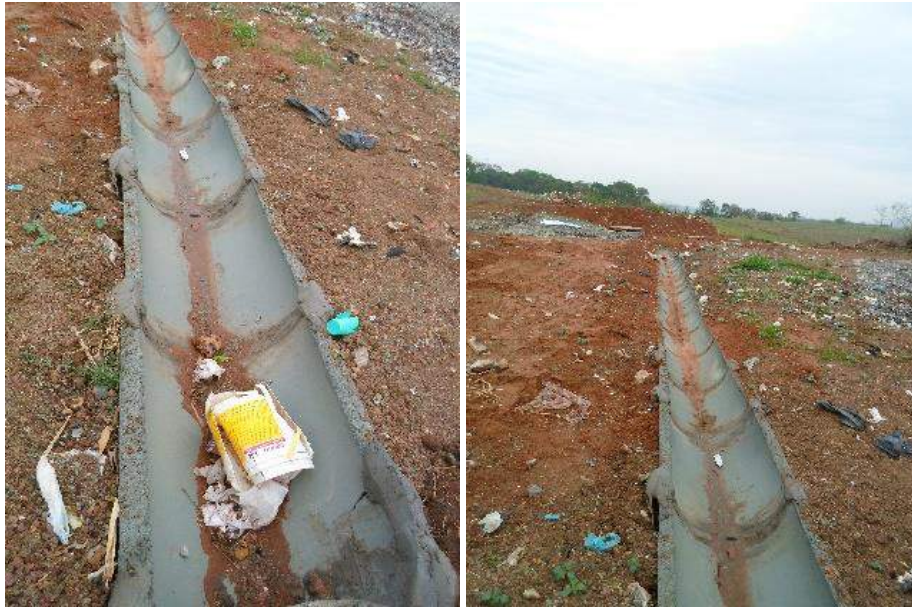
Figura 61 - Canaleta de escoamento.
