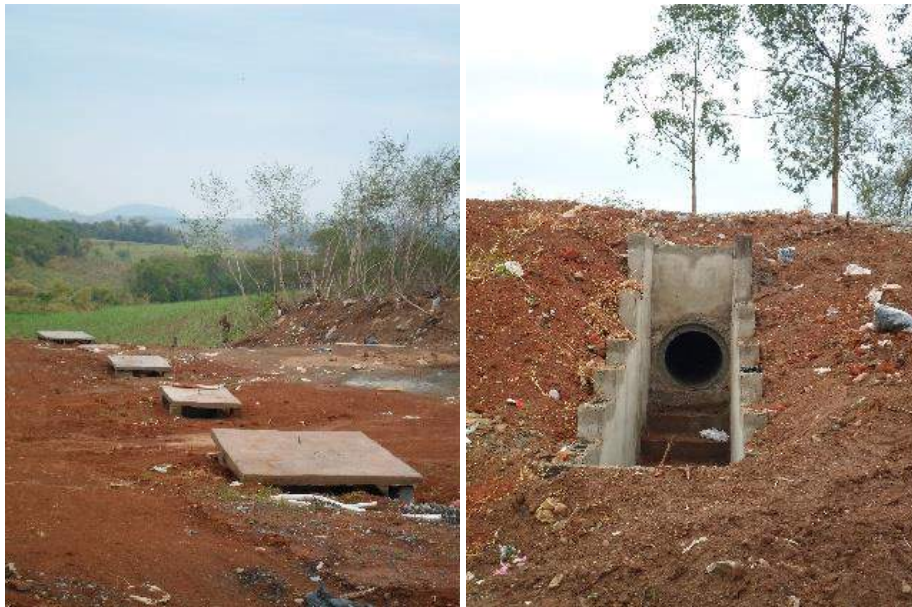
Figura 62 - Galerias para escoamento de águas pluviais.
