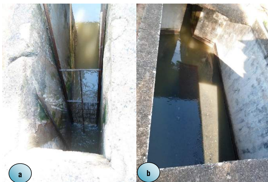
Figura 40 - (a) Gradeamento; (b) Caixa de areia.
