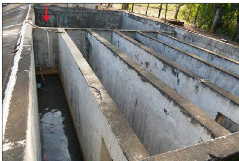
Figura 46 - Adição de cloro e tanque de contato.
